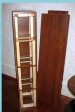
В корпусе установлены 4 распорки
